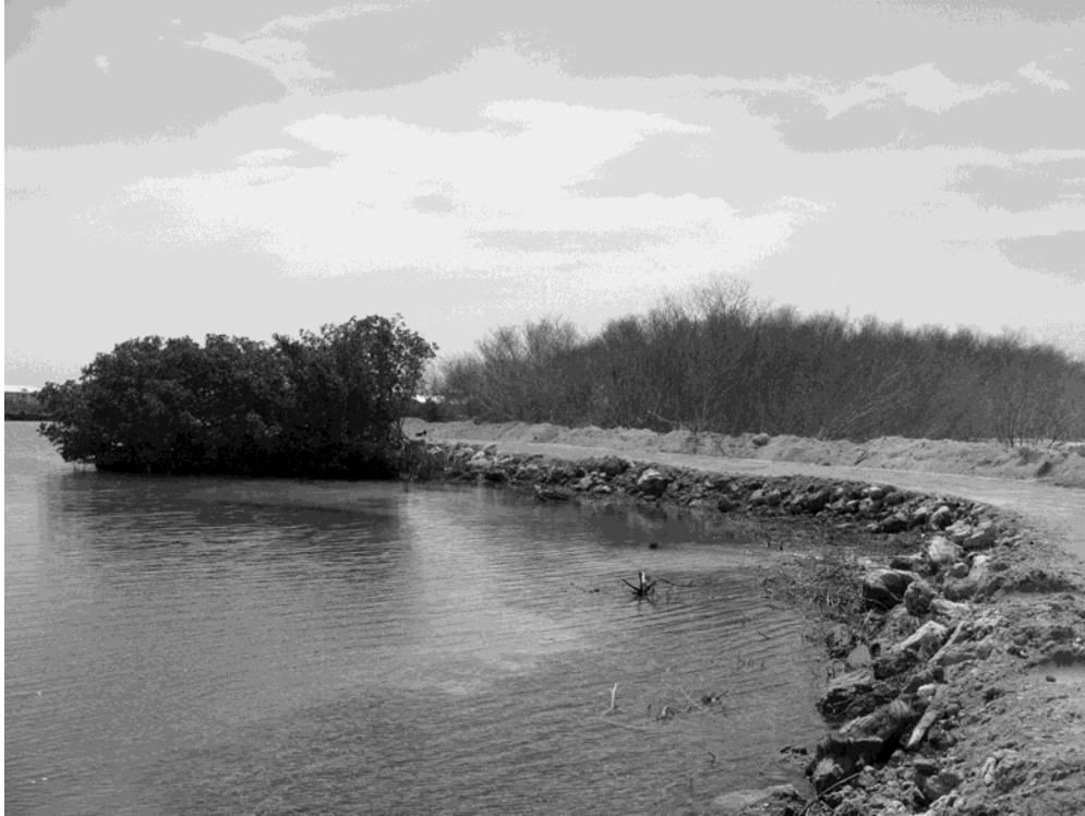
Figura 2. Vista de afectación al bosque e mangle por A: construcción de marina y B: Construcción de viales
