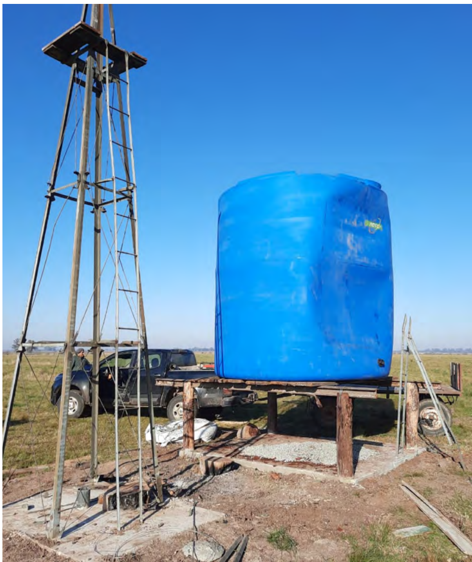
TORRE DE EXTRACCIÓN DE AGUA Y TANQUE DE DEPÓSITO
