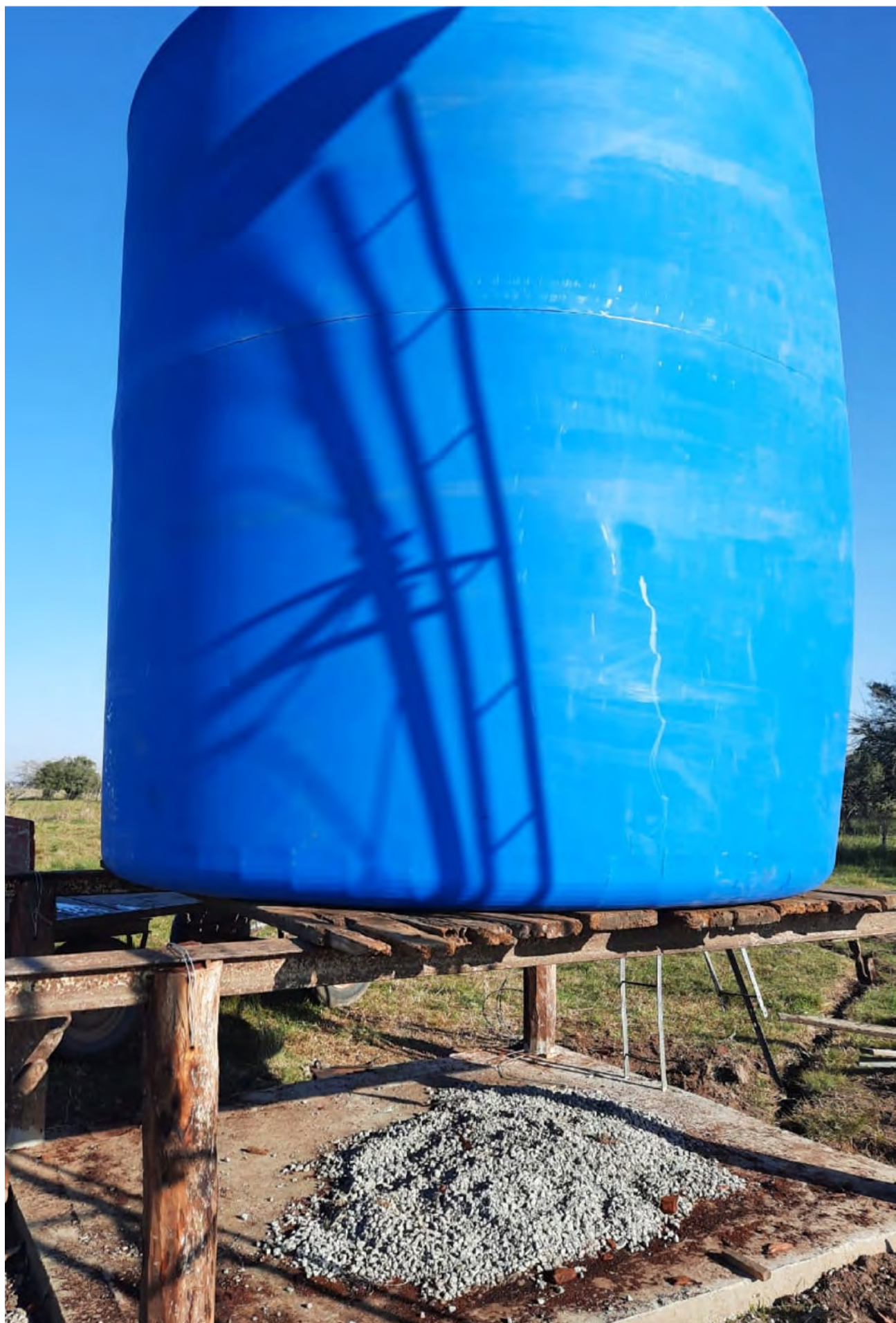
COLOCACIÓN DE TANQUE DE AGUA SIBRE PLATAFORMA
