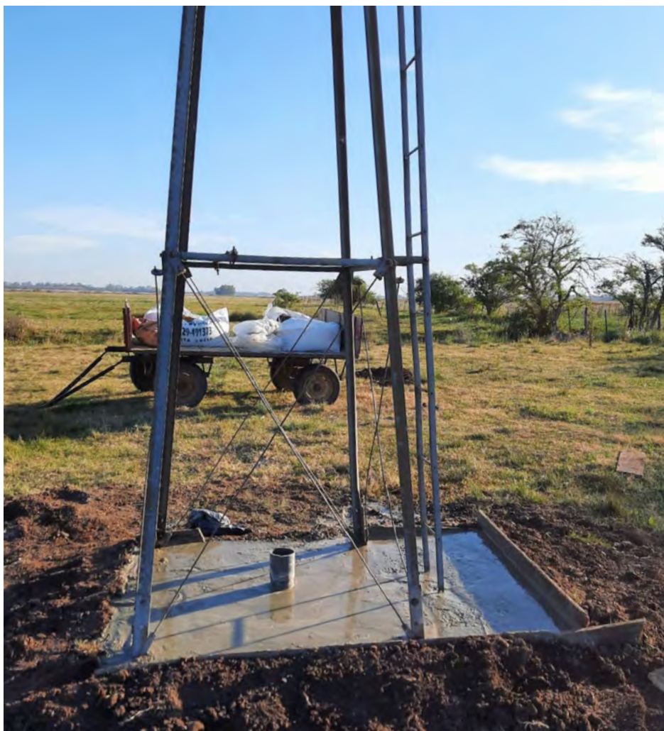
CONTRAPISO PARA TORRE DE EXTRACCIÓN DE AGUA
