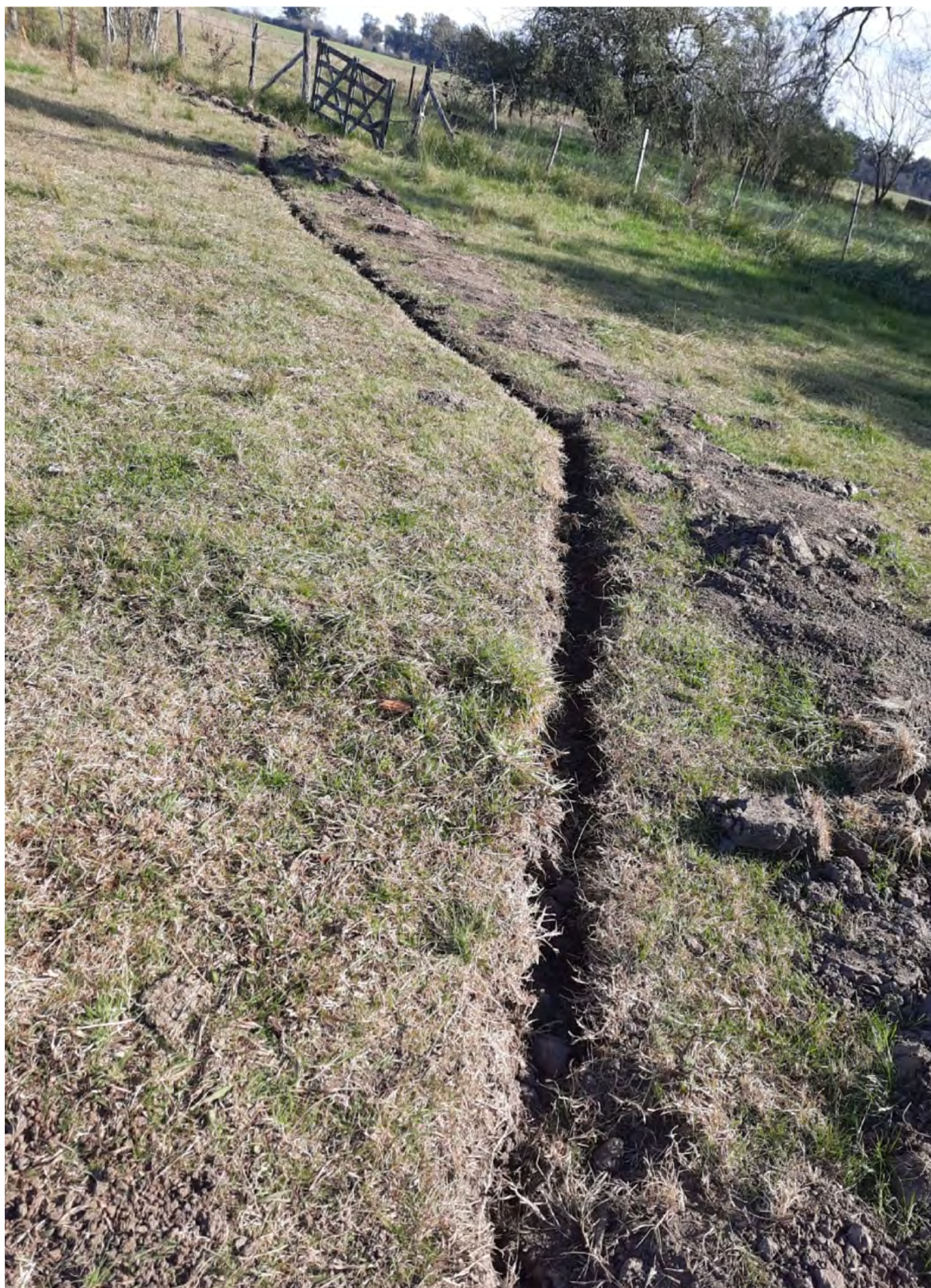
ZANJE PARA COLOCACIÓN DE CAÑOS PARA BEBEDEROS
