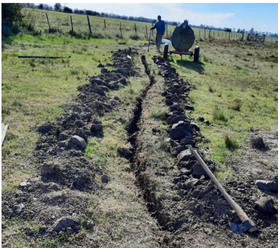
ZANJEO PARA COLOCACIÓN DE CAÑOS PARA BEBEDEROS
