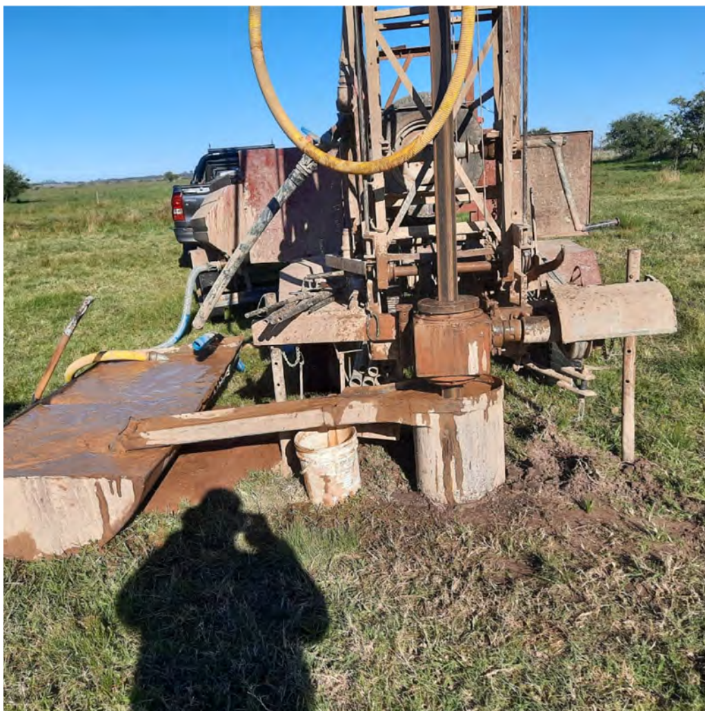
PROCESO DE PERFORACIÓN Y ENCAMISADO
