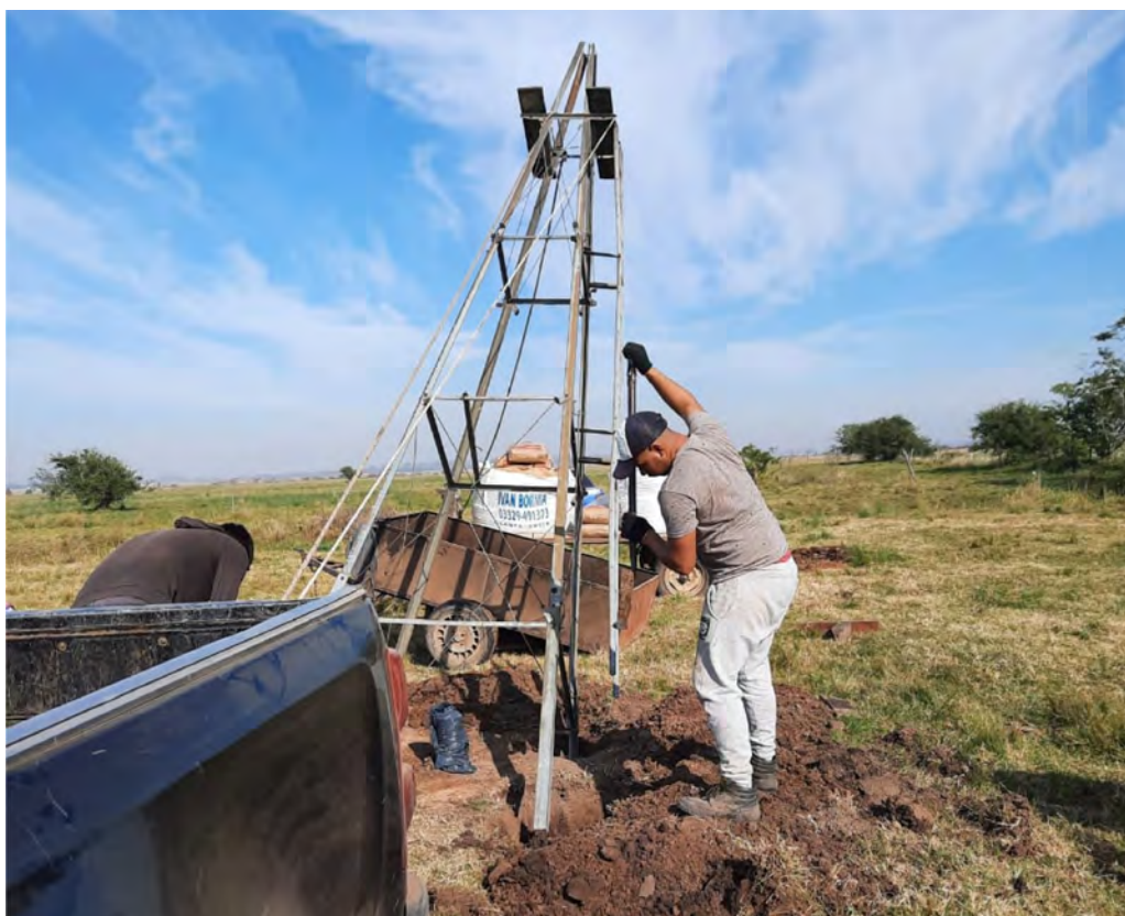
COLOCACIÓN DE TORRE PARA EXTRACCIÓN DE AGUA DEL ACUIFERO SUBTERRANEO
