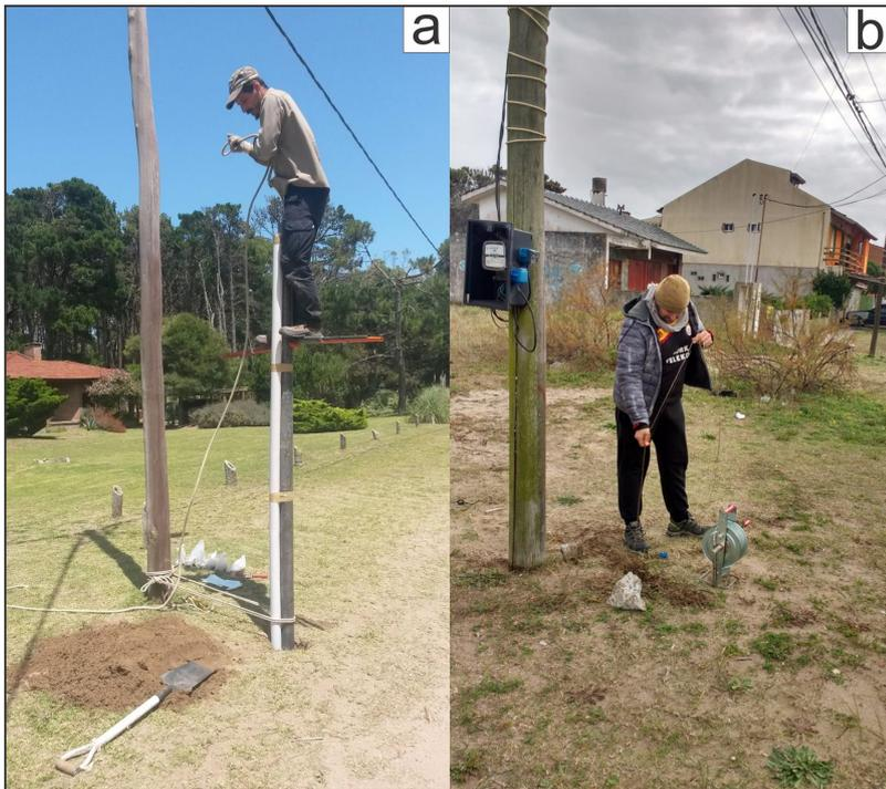
**Figura 3.** a) Ejecución de freatímetro para red de monitoreo en Villa Gesell. b) Medición manual de nivel freático con sonda de nivel en Aguas Verdes.
